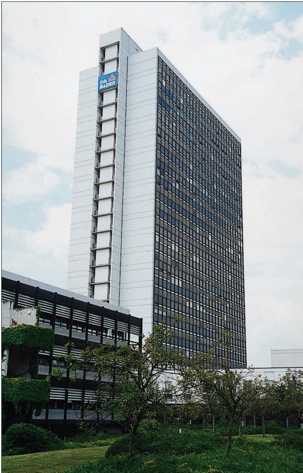
Der Hauptsitz der LVA Baden-Württemberg in der Karlsruher Südweststadt ist zugleich das höchste Bauwerk der Fächerstadt, mehr als 20 Stockwerke hoch. Foto: sj
