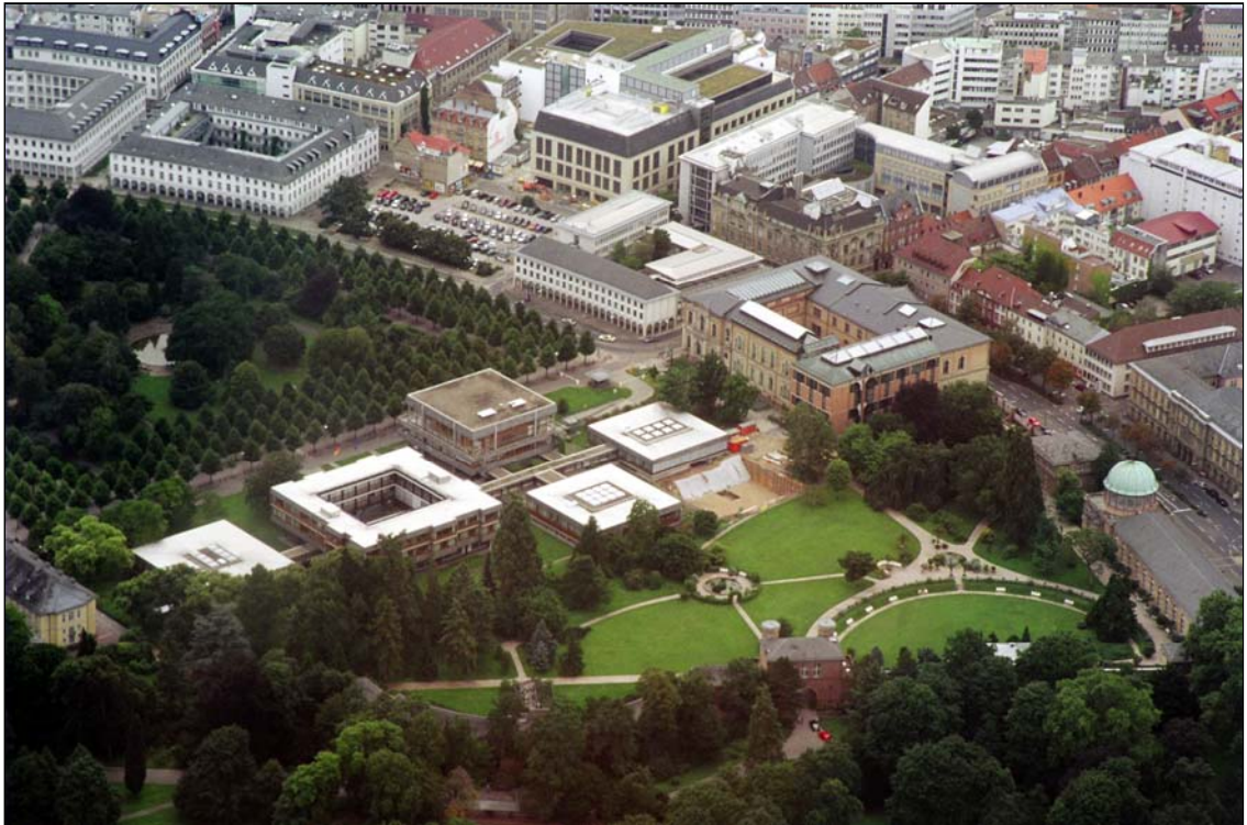
Das Bundesverfassungsgericht im ehemaligen Botanischen Garten und unweit des Karlsruher Schlosses aus der Luft betrachtet. Foto: sj
