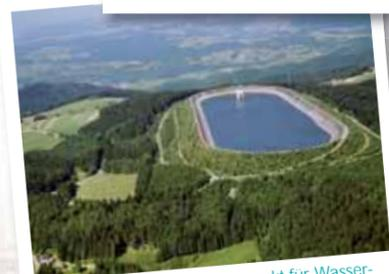
Hochrheingebiet als Schwerpunkt für Wasserkraftwerke: das Foto zeigt das 1975 entstandene Hornbergbecken, das zum Pumpspeicherkraftwerk Wehr gehört.
